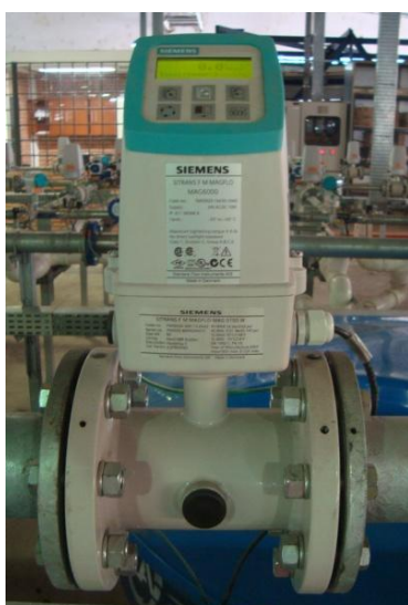
Fotografia 2: medidor de vazão eletromagnético.
